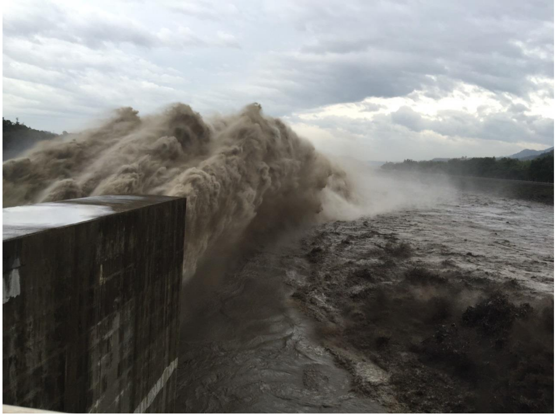
石門水庫排砂隧道可排除庫底高濁度原水，有效減緩水庫淤積
