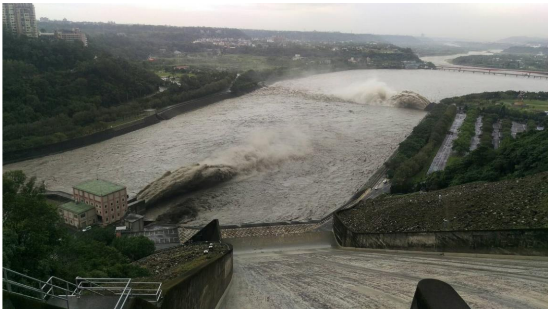
石門水庫排砂隧道進行排砂(最左)，右側為排洪隧道同時進行排洪操作
